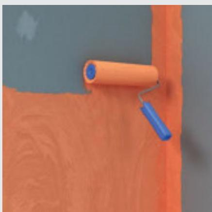
Imagen 7: Aplicar película impermeabilizante **fermacell** con rodillo a dos manos en toda la superficie (espesor mín. 0,5 mm)
