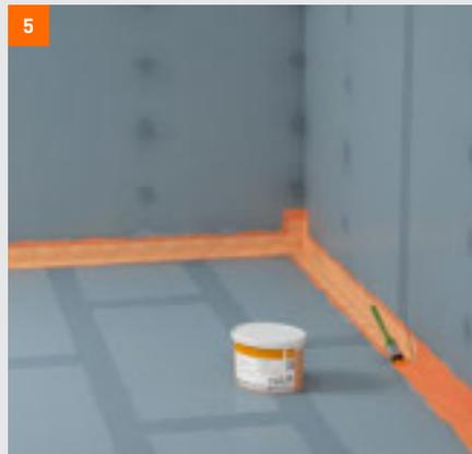
5 Aplicar directamente película impermeabilizante **fermacell** sobre la banda de sellado
