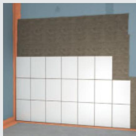
Imagen 6: Alicatado con mortero cola **fermacell** (aseguramiento de la impermeabilidad en clase de exposición A01)
