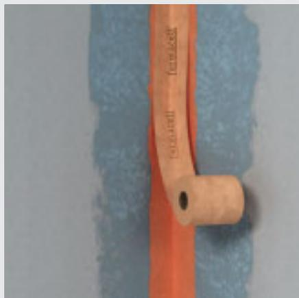
Imagen 2/3: Pegar banda de sellado **fermacell** a película impermeabilizante **fermacell** y volver a aplicar película impermeabilizante **fermacell**
