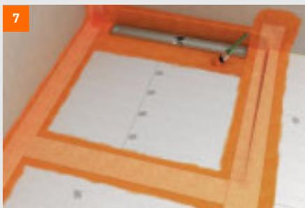
7 Sellar encuentros con elementos constructivos contiguos con elementos de sellado **fermacell** (bandas de sellado y esquinas de sellado) y película impermeabilizante **fermacell**. Impermeabilizar íntegramente la zona con pendiente (película impermeabilizante a 2 manos).
