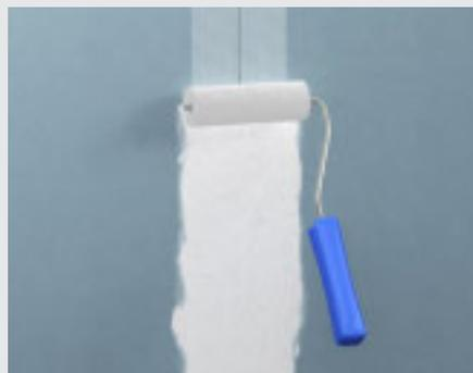
Aplicación del pegamento de refuerzo HD sobre la cinta de refuerzo
