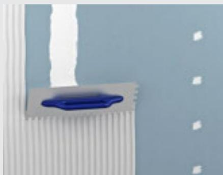
Aplicación de la capa base de mortero ligero HD (espesor 5-6 mm). La capa base debe armarse con una malla de fibra de vidrio.
