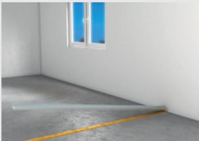
Colocación de los canales UW en el suelo con bandas acústicas
