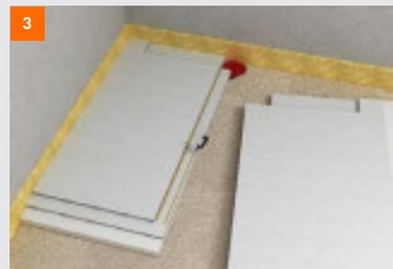
3 Colocar el primer elemento del kit, aplicar pegamento de suelos **fermacell** sobre el machihembrado, pegar segundo elemento y atornillar.
