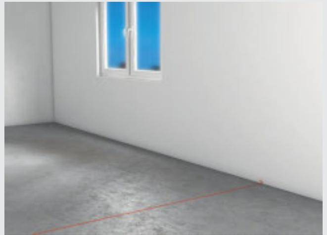
Disposición de los ejes de pared con un tiralíneas o mediante un láser
