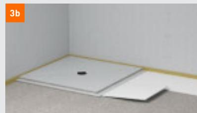
**Variante B:** para llegar a la cota superior de la lengüeta del machihembrado se colocan planchas de poliestireno (EPS 150kPa\*) de 10 mm de espesor en toda la superficie
