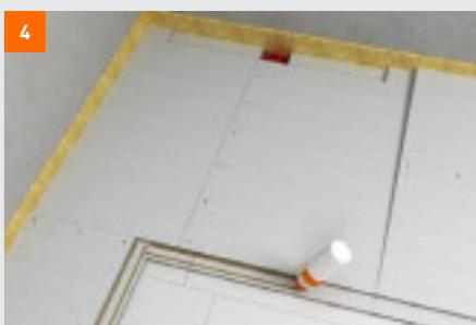
4 Los elementos de suelo Powerpanel TE deben rejuntable a tope con el los elementos del desagüe lineal Powerpanel. Pegar y fijar mecánicamente los elementos Powerpanel TE.
