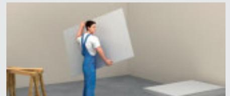
Transporte individual de los paneles **fermacell** en vertical
