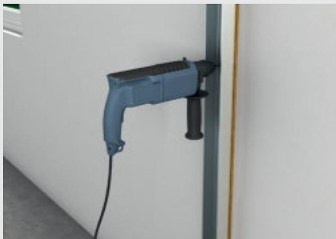
Fijación de los montantes CW de arranque con bandas acústicas
