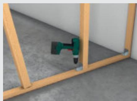
Montaje de los montantes de madera con tirafondos o angulares metálicos
