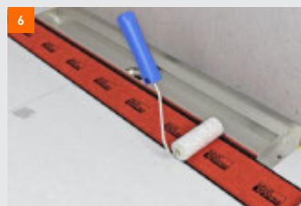
6 Pegar la cinta impermeabilizante de butilo sobre canal y elemento de desagüe, presionar sin crear pliegues y solapar esquinas.
