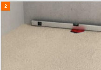
2 Preparar mezcla de recrido **fermacell** y extender hasta cota superior del elemento de desagüe (aprox. 95 mm), nivelar y comprobar planimetría.
