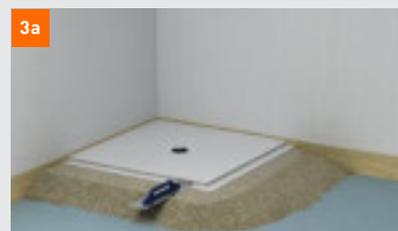
**Variante A:** Alrededor del elemento de ducha se vierte y nivela una franja de mezcla de recrecido **fermacell** (ancho 200 mm) hasta la cota superior de la lengüeta del machihembrado - como apoyo y referencia para el resto de la superficie
