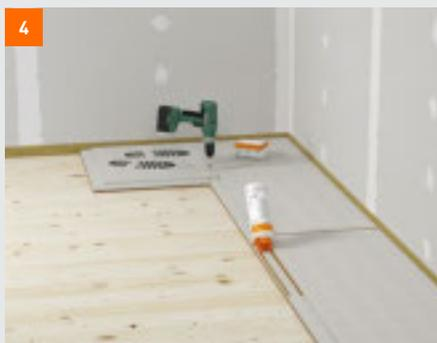
4 Aplicación del pegamento de suelos **fermacell** sobre el machihembrado
