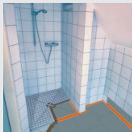
Imagen 9: Suelos así como duchas sin barreras arquitectónicas pueden realizarse con paneles de solera seca Powerpanel TE
