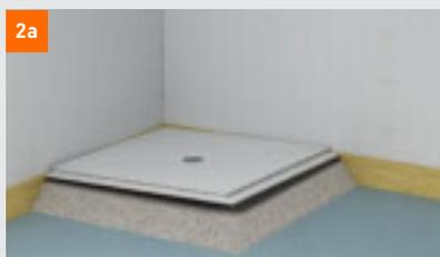
**Variante A:** Se vierte y nivela la mezcla de recrecido **fermacell** en la zona del elemento de ducha hasta la altura del canto superior del elemento de desagüe y se coloca el elemento de ducha
