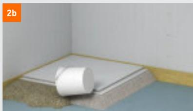
Se vierte y nivela la mezcla de recrecido **fermacell** hasta la altura del canto superior del elemento de desagüe en toda la superficie y se coloca el elemento de ducha
