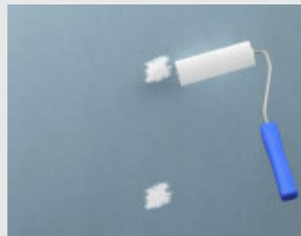
Aplicación del pegamento de refuerzo HD sobre las fijaciones (mediante ligeros toques)
