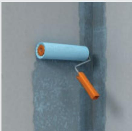
Imagen 1: Aplicación de la imprimación **fermacell**
