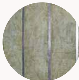
3. Colocación del aislamiento URSA TERRA/
